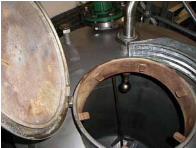
Povrchová koroze - před a po odstranění pomocí Avesta Cleaner 401.
