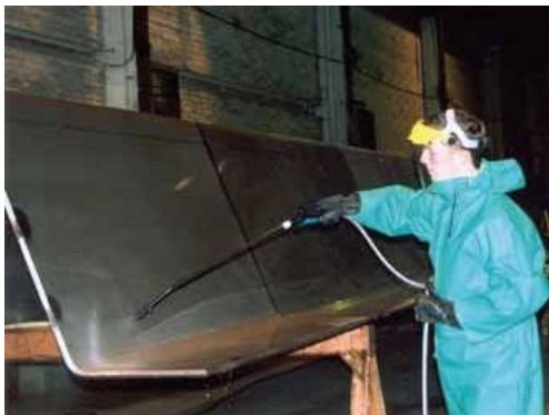
Pasivace dílu, který bude součástí objemného chemického tankeru z oboustranné nerezové oceli
